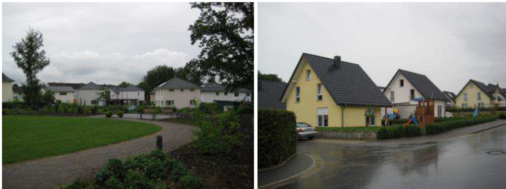
Fotos 1-2: Solarsiedlung und Neubaugebiet an der Robert-Kronfeld-Straße (Quelle: GEWOS)
