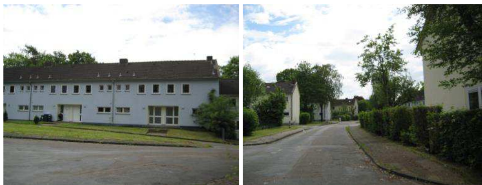
Fotos 7-8: Reihenhausbauung im Süden und Osten der Siedlung 1 (Quelle: GEWOS)
